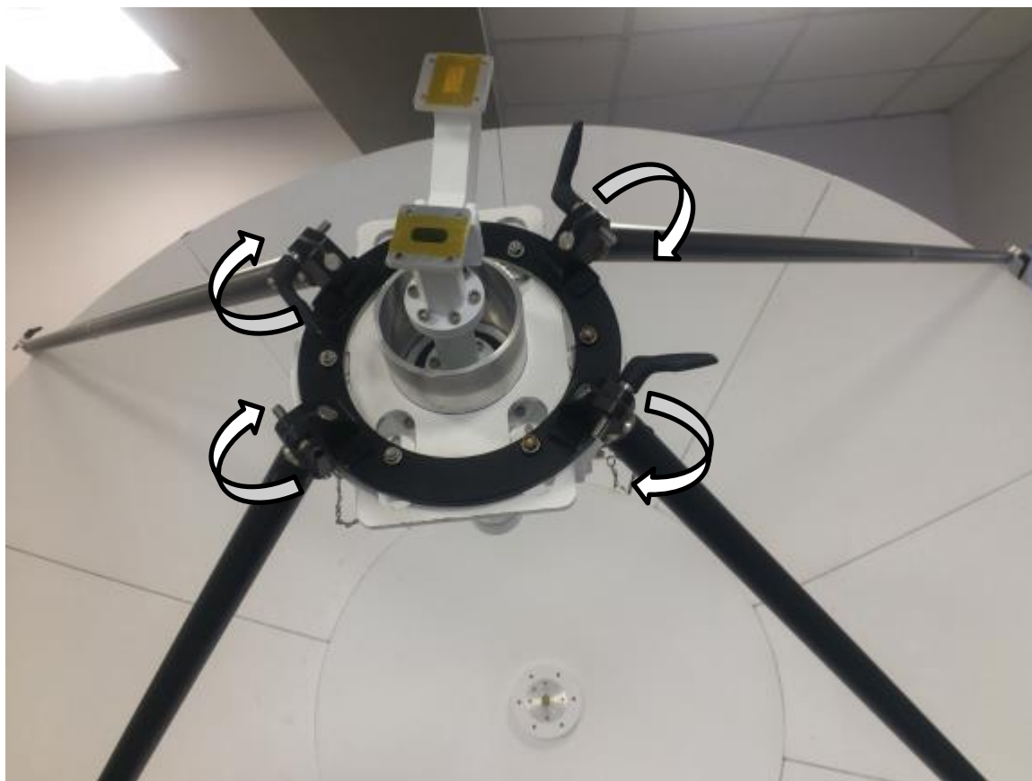
Рисунок 2.2.1.8.1 – Установка ОУ
